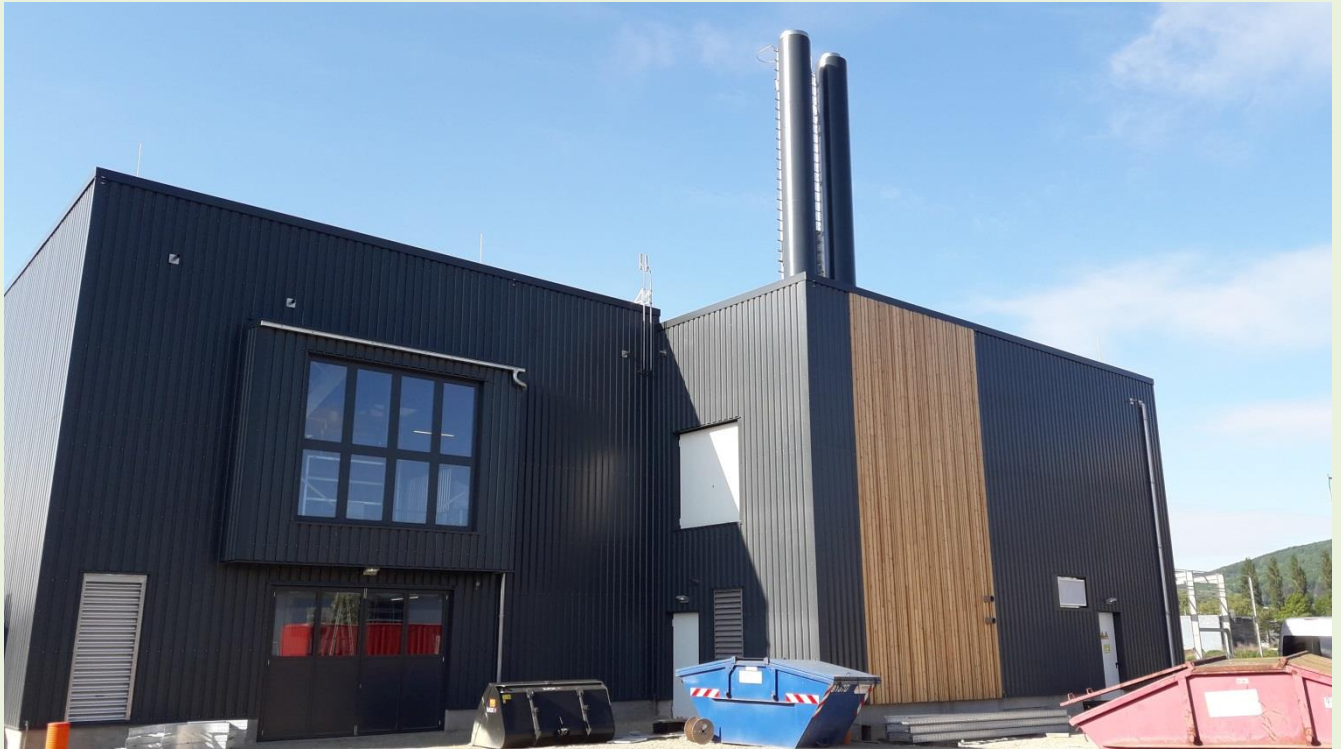
Das Heizwerk mit Wasserdampffahne über dem Schornstein.
