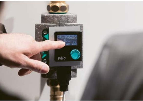
Besonders energiesparende Umwälzpumpen (Hocheffizienzpumpen) mit einer selbsttätigen elektronischen Regelung können sich bis zu 5 Watt Verbrauchsleistung herunterregeln.
