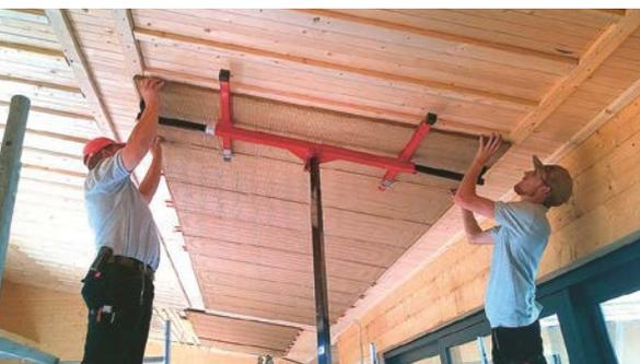
Deckenheizungen aus Lehm stellen eine bauphysikalisch sichere und raumklimatisch attraktive Alternative zu konventionellen Systemen dar. Insbesondere bei höheren Räumen eignet sich die Deckenheizung mit einem hohen Strahlungsanteil von 90 Prozent als Heizvariante.
