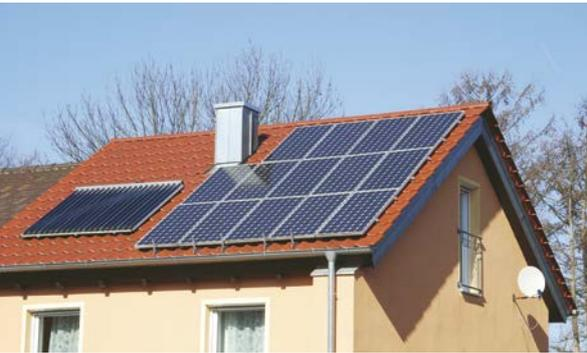
Photovoltaik und Solarthermie lassen sich oft auch gut kombinieren.
