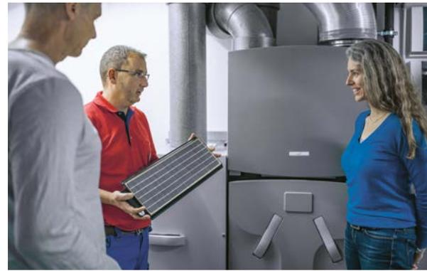
Eine Lüftungsanlage mit Wärmerückgewinnung ist neben der CO<sub>2</sub>-Einsparung auch eine durchaus wirtschaftliche Baumaßnahme, denn sie kann die Heizkosten bis zur Hälfte senken und schützt das Gebäude vor Feuchteschäden durch fehlerhaftes Lüften.
