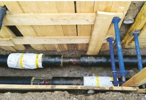
Ein kaltes Nahwärmenetz hat viele Vorteile – beispielsweise müssen die Leitung nicht stark gedämmt werden.
